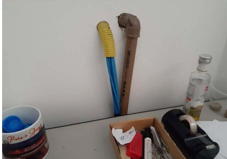
Figura 10 - Cabos de rede passados em dutos de rede elétrica
